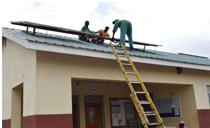
Installazione dei nuovi pannelli solari
