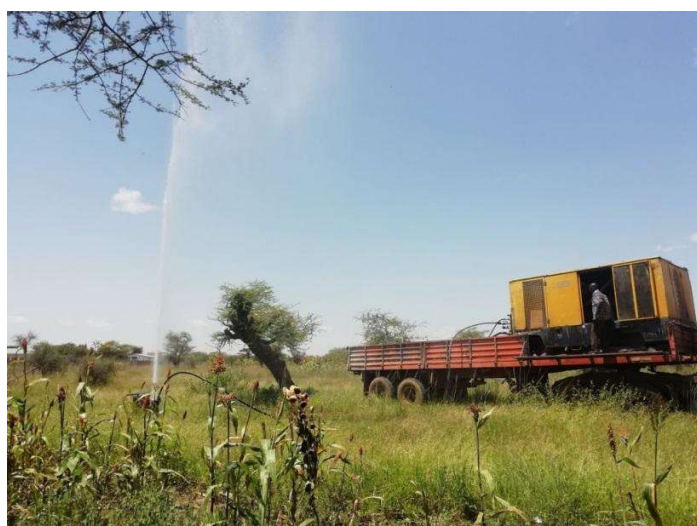
Operazioni di blowing e recupero del pozzo
