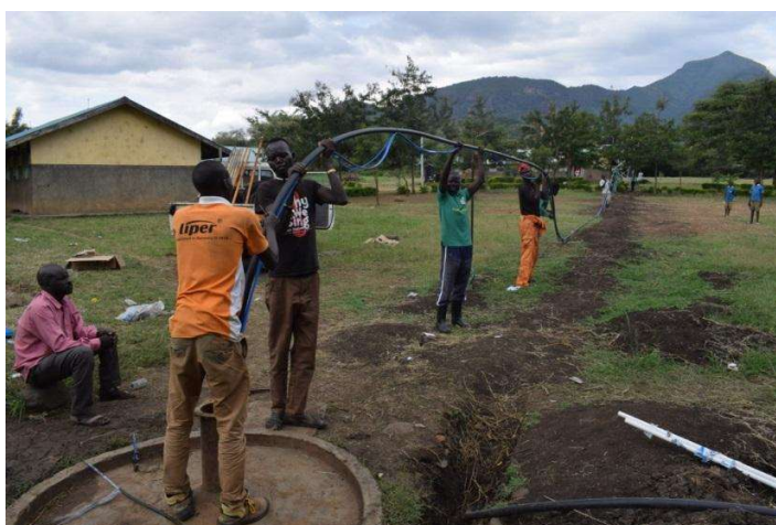
Posizionamento dei pannelli e della pompa solare; posizionamento dei tubi di collegamento.
