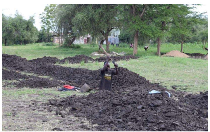
Scavo dei canali di connessione dei tank e del pozzo alle cucine, ai bagni, al water point e al sistema di irrigazione Water point e sistema di irrigazione nella scuola
