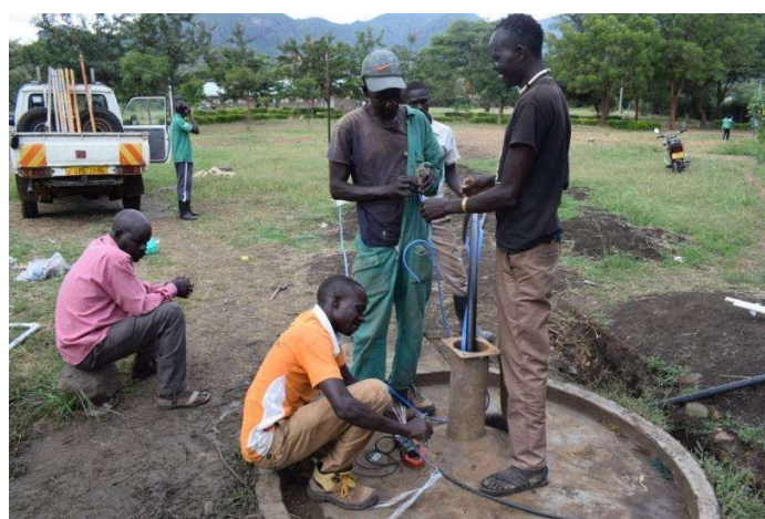
Posizionamento dei pannelli e della pompa solare; posizionamento dei tubi di collegamento.
